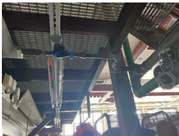
Päävesimittari
