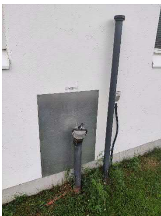
Purkamattomat öljyntäyttö-yhteet.
