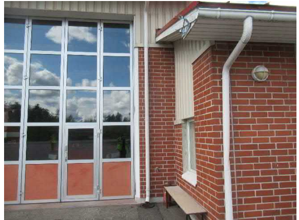
Yleiskuva syöksytorvista ja sadevesikouruista
