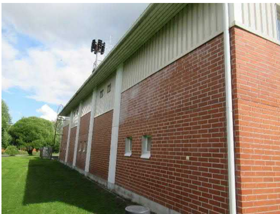
Kalkkihärmettä tiilimuurauksessa
