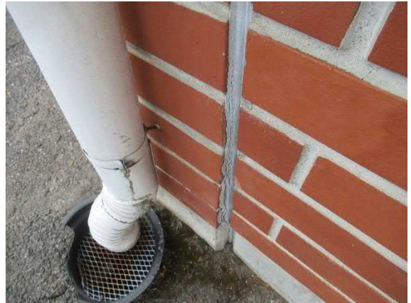
Sadevedet johdettu osittain sadevesikaivoihin
