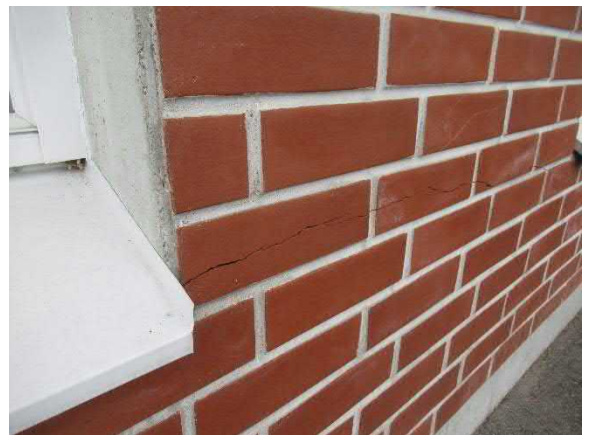
Halkeama tiilimuurauksessa
