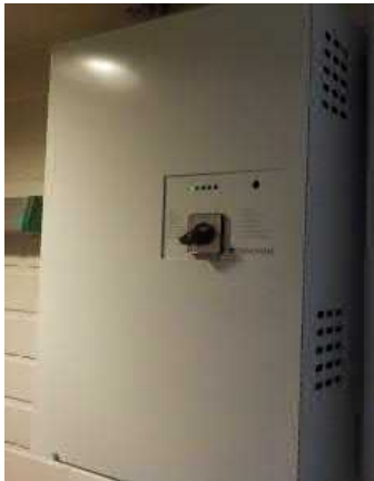
Turvavalokeskus näyttämön läheisyydessä
