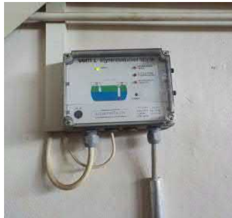
Öljynerotuskaivon ohjauskeskuksen sähköistystä
