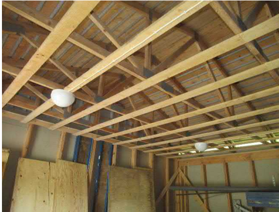
Yleiskuva varastorakennuksen sisäpuolelta
