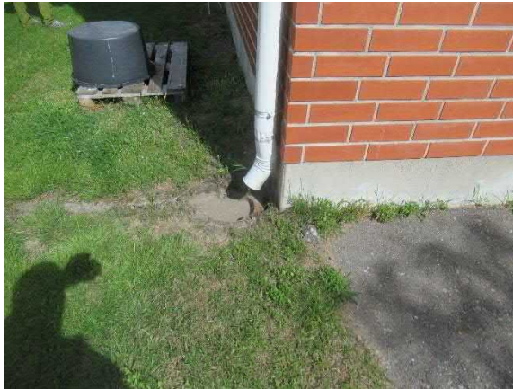
Sadevedet johdetaan syöksytorvien avulla viemurustoille / loiskekivikouruihin
