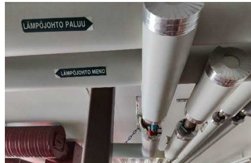
Lämpölinjat kalustohallissa. Eristykset hyvässä kunnossa.
