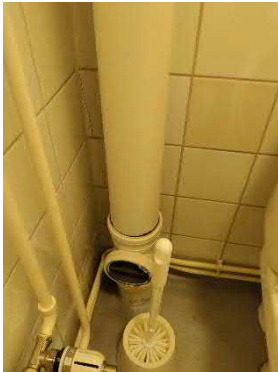
Sisäpuolinen muoviviemäri.
