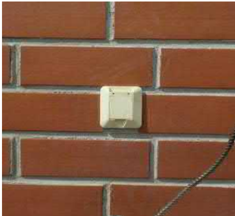
Pistorasia ulkoseinällä
