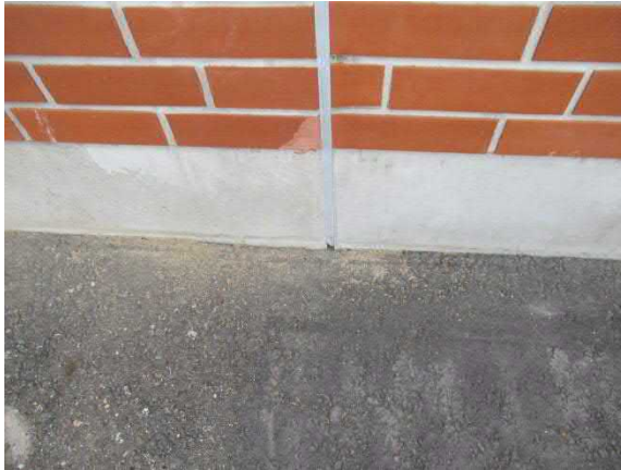
Elementtisauma auki maanpinnan tasalta (käsitelty kohdassa: Ulkoseinät
